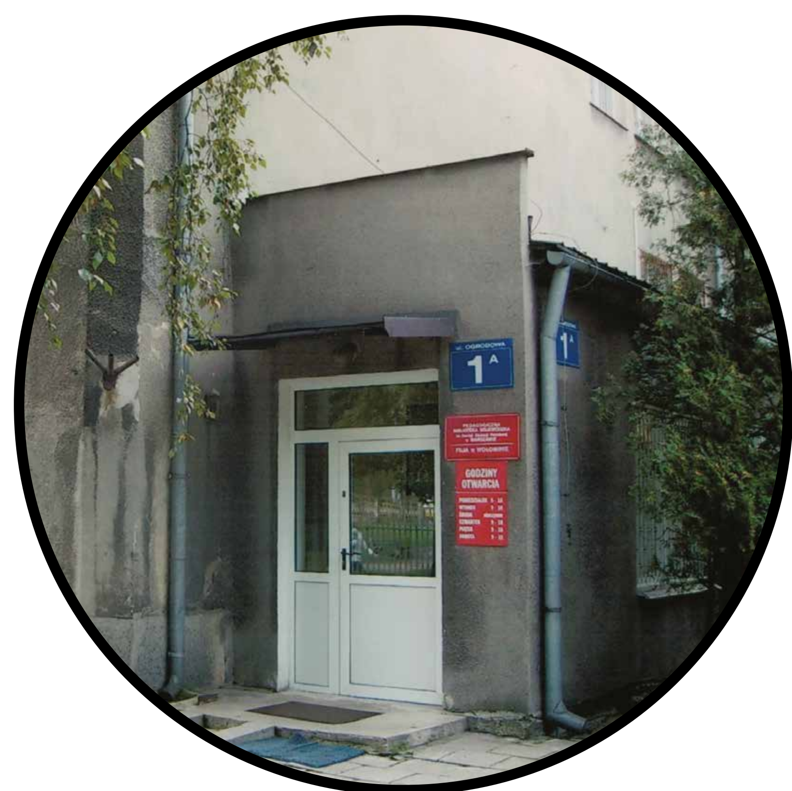
Wołomin, ul. Ogrodowa 1A, wejście główne do Biblioteki Pedagogicznej, 2010 r.
